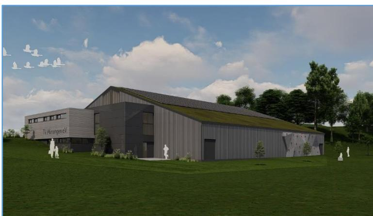
Ansicht von der Freibadliegewiese aus. Die beiden Spielfelder sind in der unteren Ebene (EG), ebenso der Gymnastikraum (unter den Umkleidekabinen). An der Außenwand könnte eine vom Freibad aus zugängliche Boulderwand entstehen.
